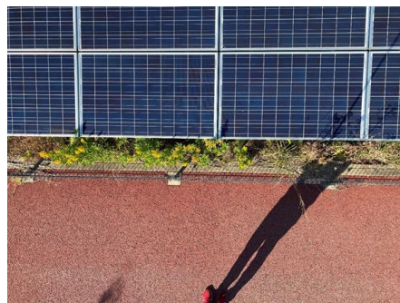
図 1 雑草影のかかった太陽電池パネルの自撮り棒を用いた上からの撮影
