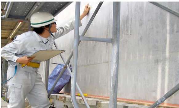
図 1 目視調査の様子
