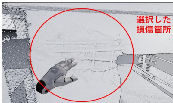
図11 損傷箇所へ移動後
