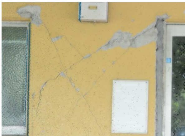
図 3 建物壁面の三次元点群データ
