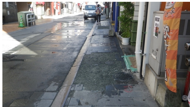
図 12 舗装がされていない歩道
