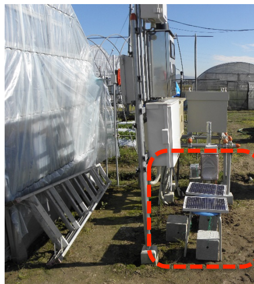
図7 ビニールハウスへの設置
